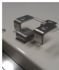
Detail eingehängte Deckenhalter
